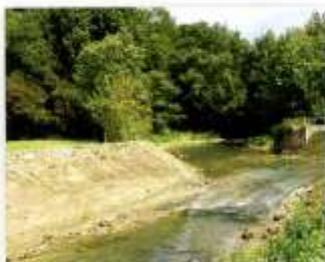
**ENFIN, TROISIÈME CHANTIER** : arasement du barrage de Guémy, reprofilage des berges, plantation d'arbres et mise en place de clôtures et d'abreuvoirs dans le but de sécuriser le site et de restaurer la libre circulation des poissons et des sédiments.
